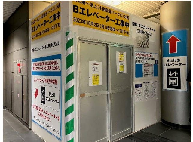
新高島駅エレベーター更新工事
